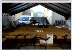
Au tour des râbles (pièces de bois solidarisant les planches du fond dans la largeur) d'être posées
