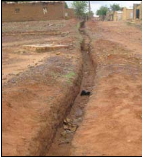
Figure 84. Photos en haut à gauche : Creusement d'une tranchée en vue de l'extension d'un réseau AEP (Moribabougou)
