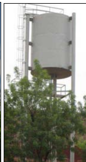
Figure 67. Photo à gauche : Château d'eau PNIR
