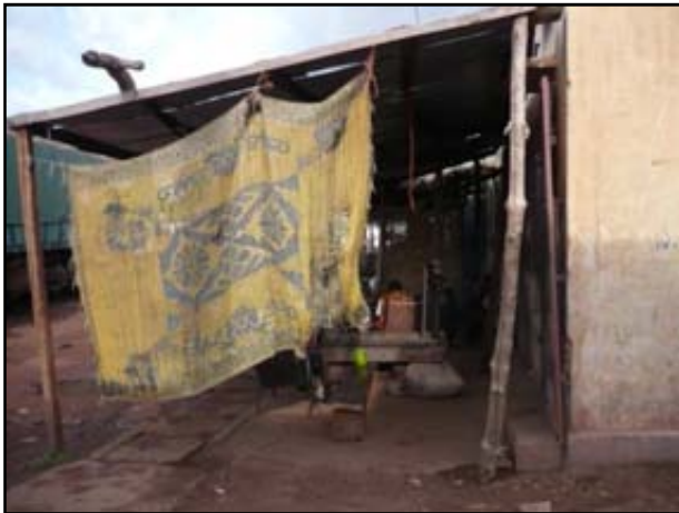
Figure 38 : Prolongement de l'utilisation d'un bâtiment en dur, source : P. Dhelens, MAK. Diallo, août 2008
