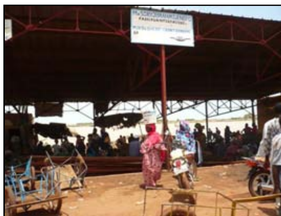
Figure 34: Hangar du chantier naval, source : P. Dhelens, MAK. Diallo, août 2008
