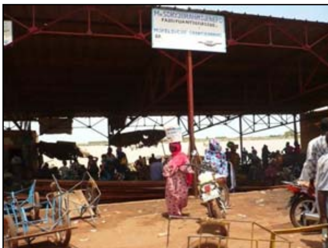
Figure 41 : Hangar du chantier naval, source : P. Dhelens, MAK. Diallo, août 2008
