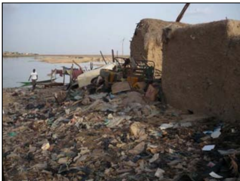
Figure 21 : Constructions sur base de remblai sur le port de pêche, source : P. Dhelens, MAK. Diallo, août 2008
