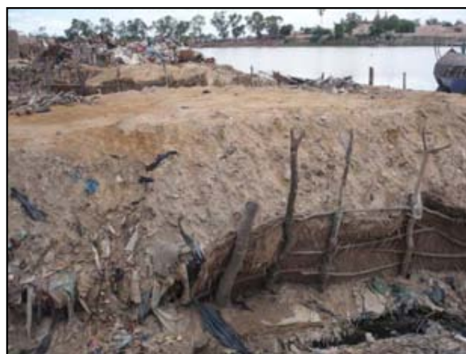
Figure 22 : Constructions sur base de remblai sur le port de pêche (2), source : P. Dhelens, MAK. Diallo, août 2008
